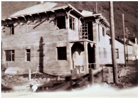
Húsið í byggingu 1944
